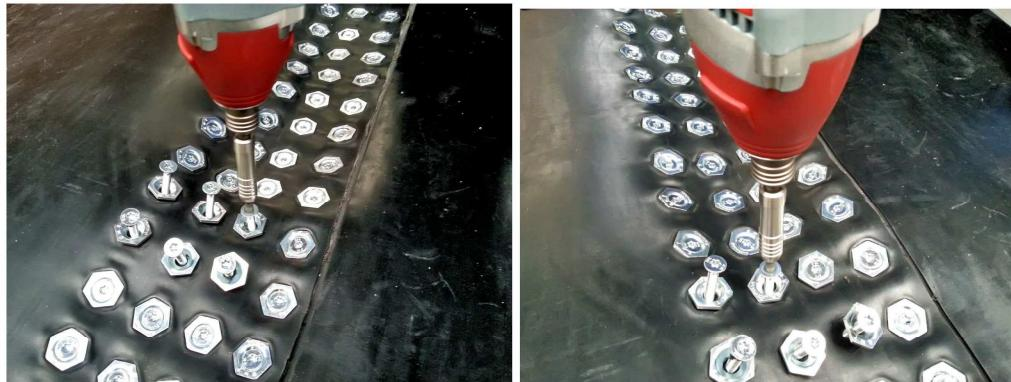
9. Все винты вворачиваем в ленту затем навинчиваем универсальную гайку-шайбу. Начинаем протяжку соединений до тех пор пока шайба не спрячется в полотно. Протяжку начинаем с середины на край.
